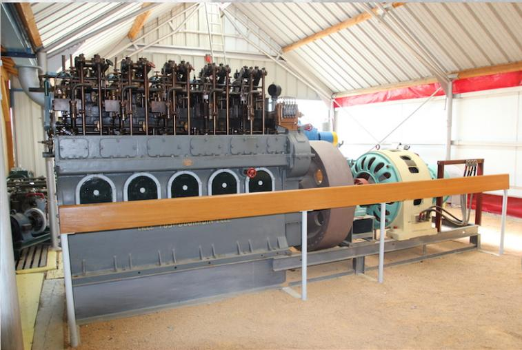
*Avant de distribuer de l'électricité, il faut la fabriquer. Ici c'est un énorme moteur diesel doté d'un non moins énorme volant d'inertie qui va fournir la puissance mécanique...*
